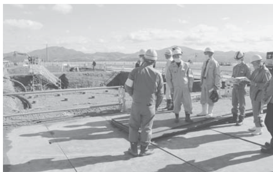
工事現場で説明を受ける
