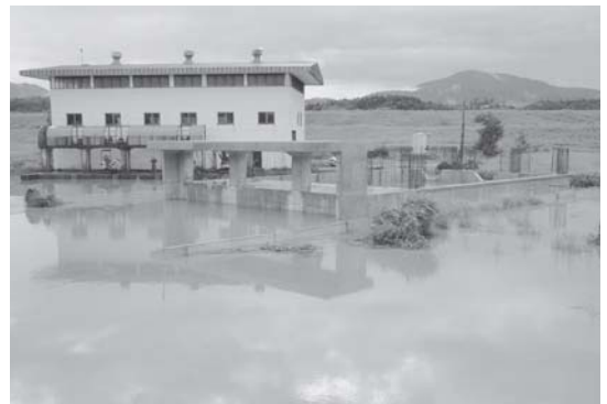
増水した誉平排水機場付近 (大富地区)
