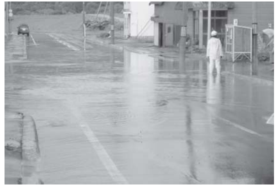
冠水した道道 (佐久地区)
