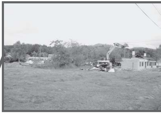
工事名：旧名寄農業開発事務所 周辺建物解体工事★ 完了：10月30日(金) 内容：建物の解体
