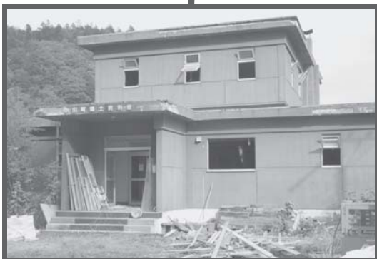
工事名：中川町郷土資料館解体工事★ 完了：10月30日(金) 内容：郷土資料館の解体
