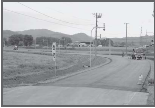
工事名：国府18線本線凍雪害防止工事★ 完了：10月30日(金) 内容：道路の路盤と舗装の工事
