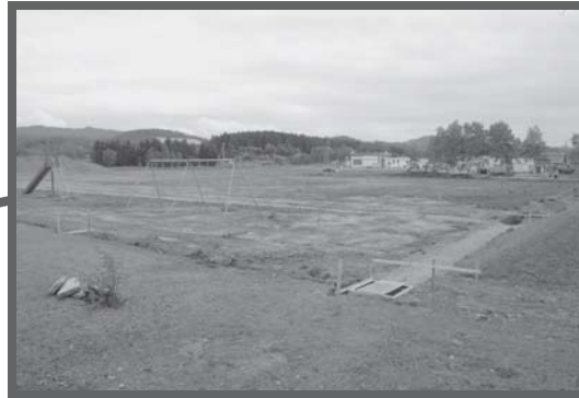
工事名：中央小学校グラウンド・多目的 広場整備工事★ 完了：11月20日(金) 内容：排水設備の整備と芝張りなど
